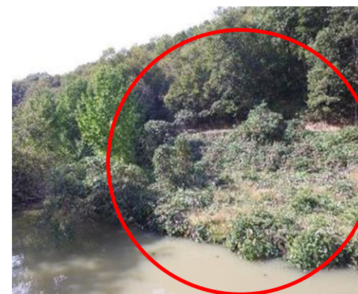
ため池への土砂流入が発生 (崩壊場所に草木が繁茂している)
