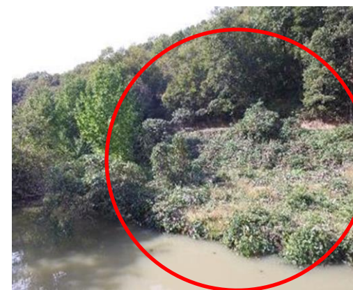
ため池への土砂流入が発生 (崩壊場所に草木が繁茂している)
