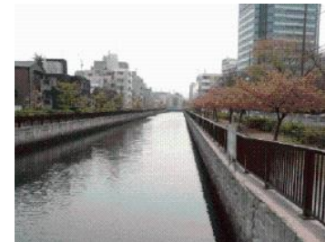
大横川（耐震護岸整備）
