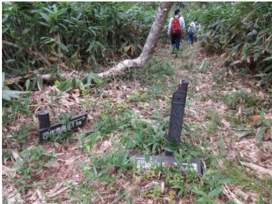
地表近くに設置された誘導標識（左）と、支柱から表示部分（腕木）が落下した誘導標識（右）
