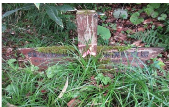
位置が低く、植生に埋もれた誘導標識
