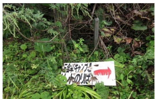
支柱から表示部分が落下した標識
