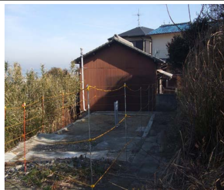
※擁壁の天端に位置していた 1 戸の除却後
