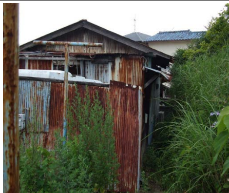
※擁壁の天端に位置している 1 戸
