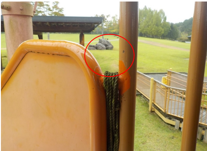
図 5. 6. 1. 1 (1) 有害な隙間の例
