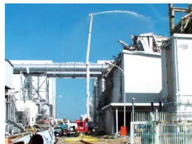
【東京電力福島第一原子力発電所3号機への放水】
