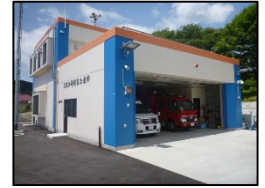
消防庁舎復旧事業 (大船渡地区消防組合 大船渡消防署三陸分署綾里分遣所)
