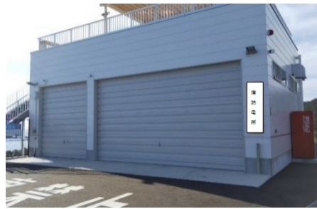
新たに建設された消防屯所
