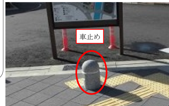
視覚障害者誘導用ブロック上に車止めが設置
