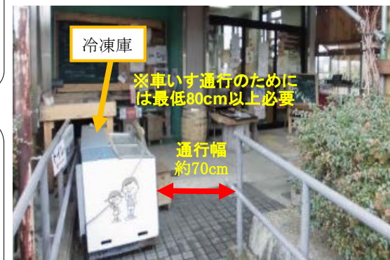
傾斜路に冷凍庫があり、車いす通行上の支障
