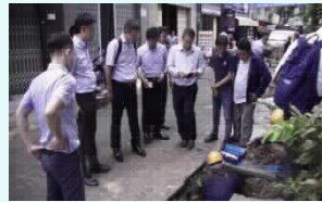
給水装置工事に関する施工技術向上プロジェクト
