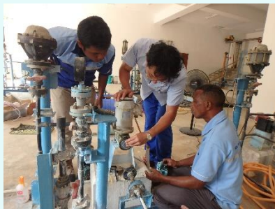
<浄水場の機器の修繕指導>
