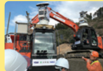
5Gによる建設機械遠隔操作の実験
