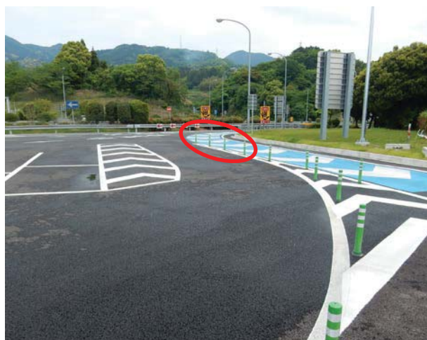
改善後(ラバーポールを追加設置)
