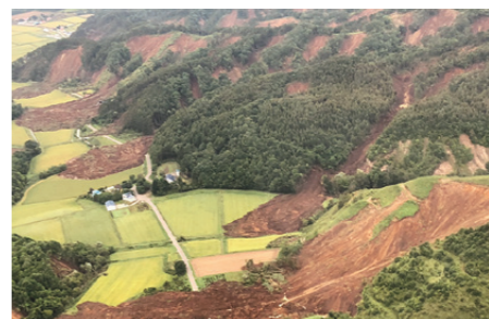
平成30年北海道胆振東部地震の被害の状況 厚真町 土砂災害(川崎市消防局提供)
