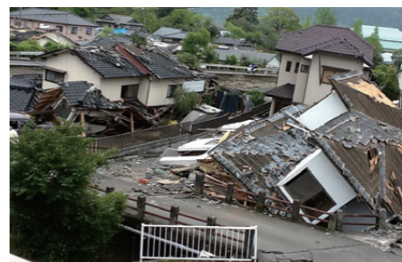
平成28年熊本地震の被害の状況 熊本県益城町(高松市消防局提供)
