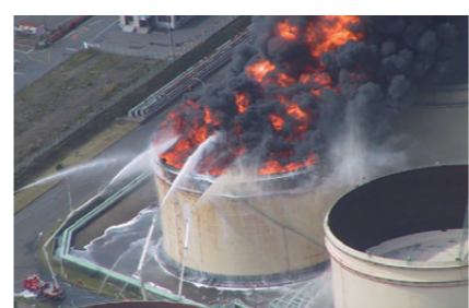
タンク火災の様子
