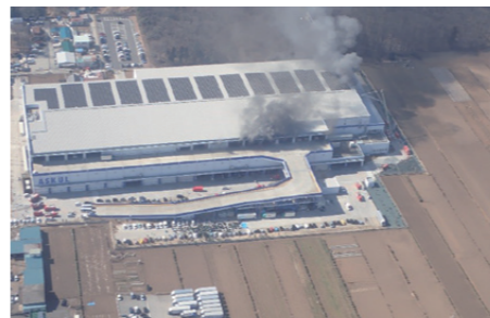
平成29年埼玉県三芳町倉庫火災の状況 (埼玉県防災航空隊提供)
