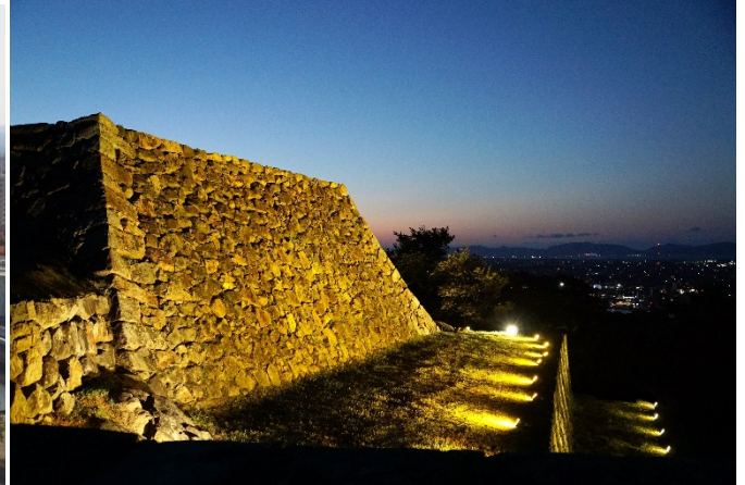
米子城跡ライトアップ(写真提供:鳥取県米子市)
