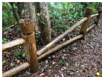
転落防止柵が一部破損している例
