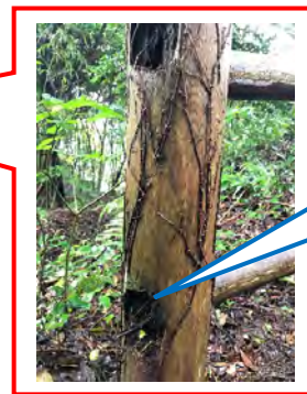
転落防止柵が破損し外れたままになっている例
