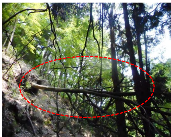
倒木が引っかかっている電線の状況
