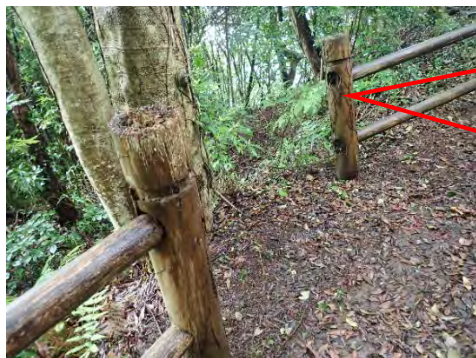
転落防止柵が一部破損している例
