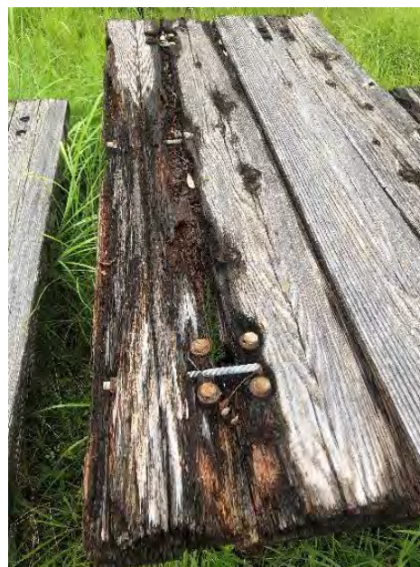
破損したまま放置されているベンチ
