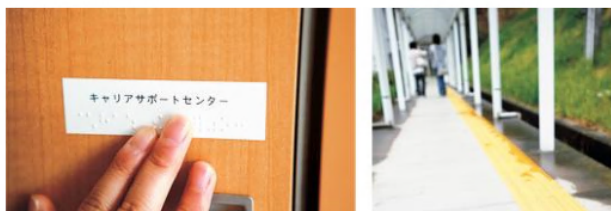
点字プレート・点字ブロック
