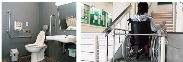
多目的トイレ・段差解消昇降機
