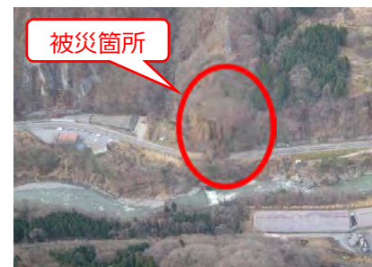
④ 国道148号：被災状況写真
