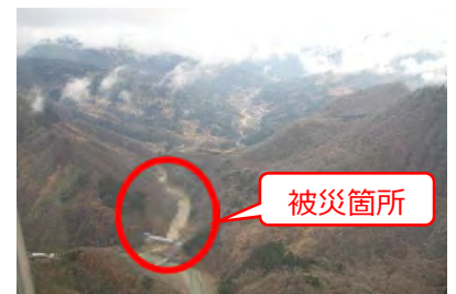
③ 中谷川：被災状況写真
