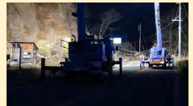
照明車による被災状況調査
