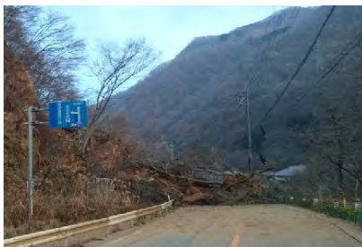
国道 148 号線 土砂崩落現場 (白馬村新田)
