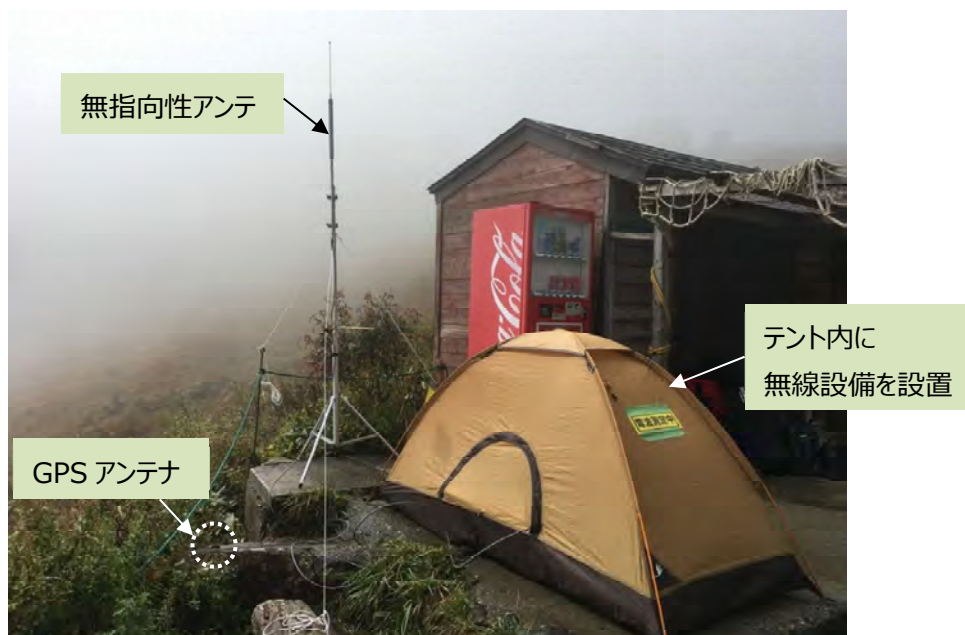
図 2-48 山岳高所側の無線設備（無積雪期）
