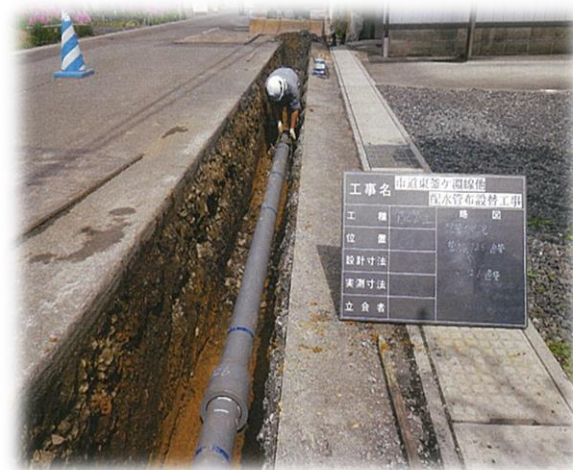
耐震管への布設替工事
