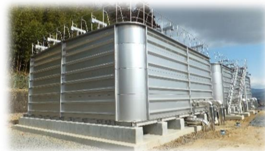
釣山配水池の更新（ダウンサイジング）
