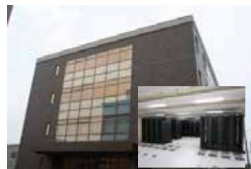
ITビジネスセンター(DC機能、ビジネス拠点)
