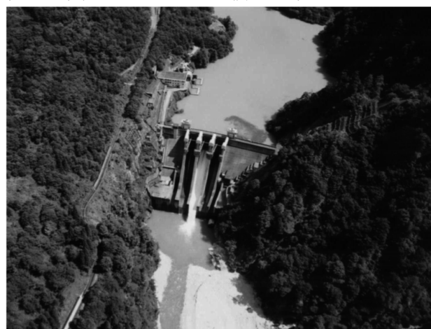
排砂中の出し平ダム
