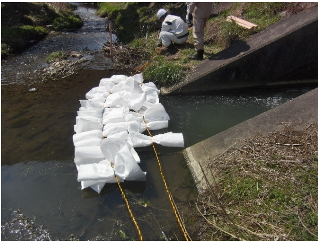
水質汚濁への対応（オイルマット設置）の様子
