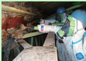
吹付け石綿の除去作業の様子
