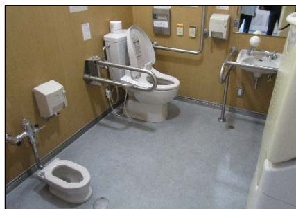
高松公共職業安定所のトイレ
