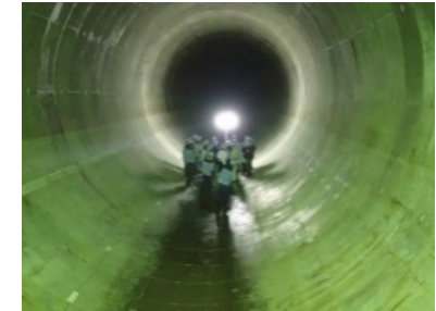
雨水貯留管の整備
