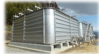
釣山配水池の更新（ダウンサイジング）
