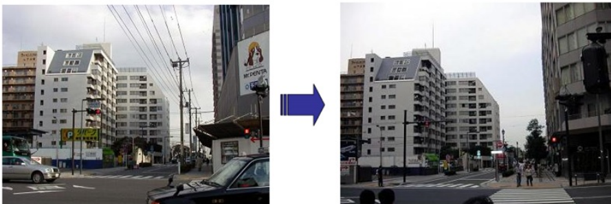
電線類の地中化の例（横浜市中区）
