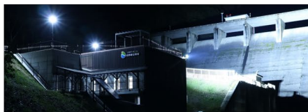
ライトアップ中の発電所
