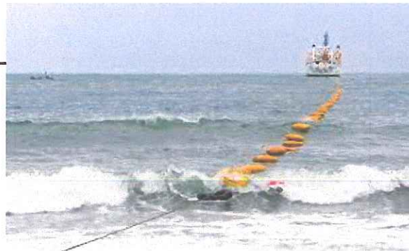
光ケーブル保守作業
