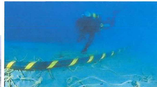
ダイバーによる保守点検
