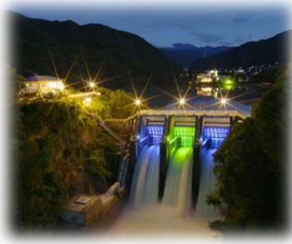
高遠ダムと高遠さくら発電所
