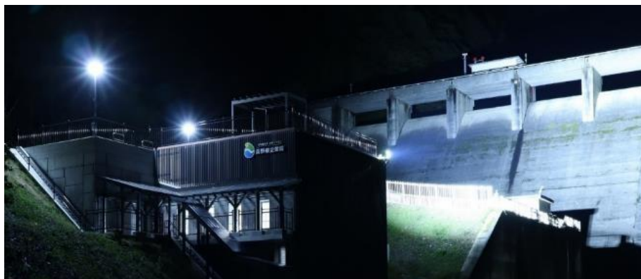
ライトアップ中の発電所
