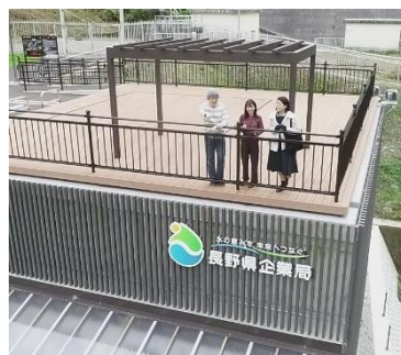
発電所/展望デッキ
