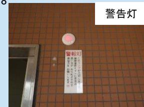
※多目的トイレ出入口
