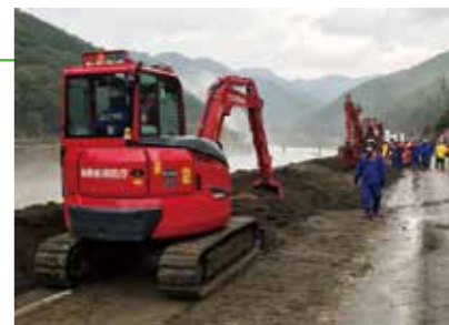
重機を活用した捜索活動（熊本県球磨村） （下関市消防局提供）
