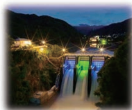
高速ダムと高速さくら発電所
