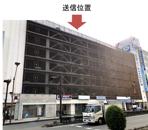
(b) 送信点設置ビル
