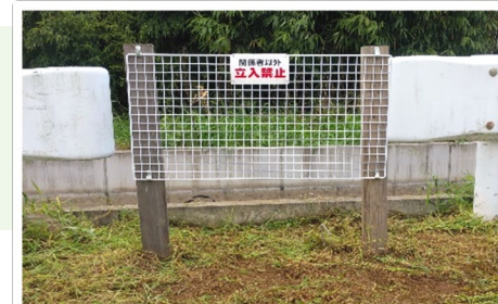
【セミハード対策の例】簡易柵を設置した応急的な転落防止策（「事例集」事例6）
