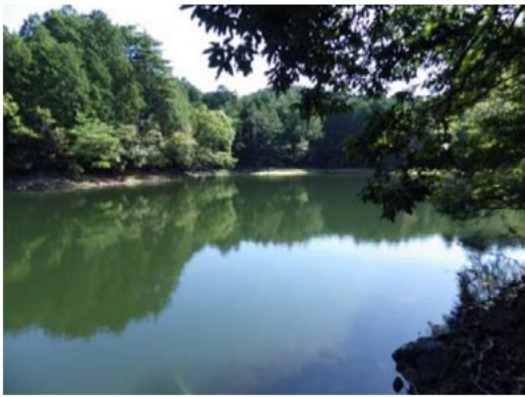
【廃止工事前のため池】
