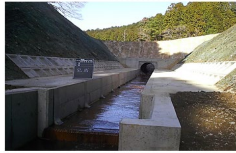
※ 新たに設置された排水管と排水路
