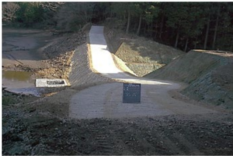
※ 新たに設置された排水口と代替林道
