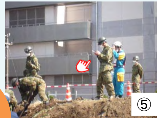
土砂崩れ現場
