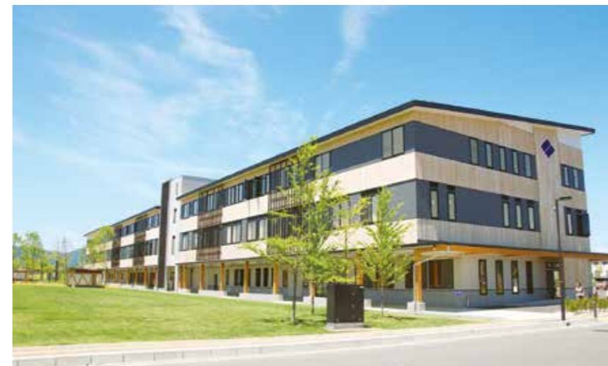
町産木材で建築した紫波町役場。木造としては国内最大級の役場庁舎。
