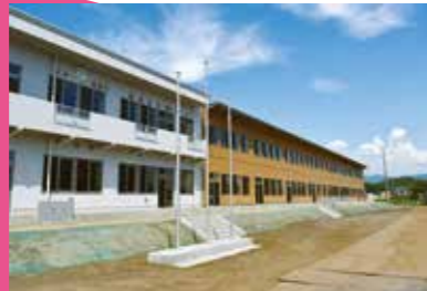
学区内で産出された木材を構造材とした紫波東学園の校舎。
