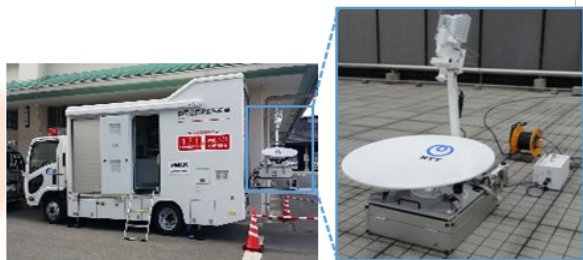
小型ポータブル衛星装置を用いた災害時用公衆電話の設置
