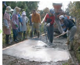
舗装材敷均し
