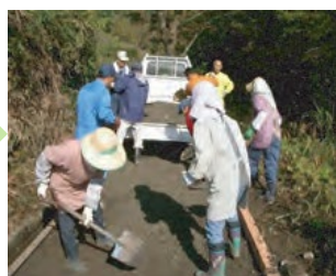
補足材敷均し
