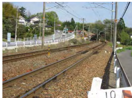
線路左から起点寄(福山駅方面)を見る
