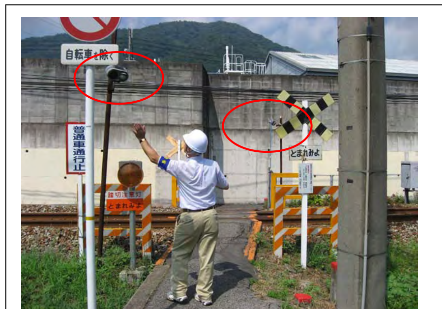
事例13:大元踏切(広島県内4種踏切、可部線、上八木駅—中島駅)
