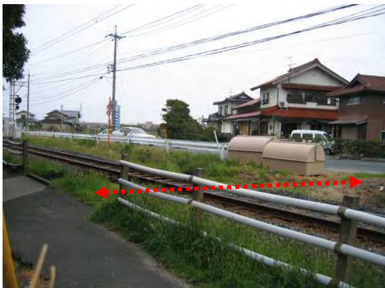
事例17:生活道(北松江線、川跡駅—大寺駅)
