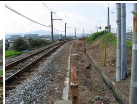
踏切から起点寄(横川駅方面)をみる
