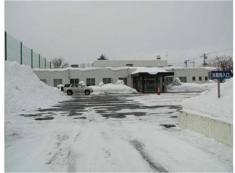
写真② 駐車スペースを示す立札等による標識が設置されていない事例
