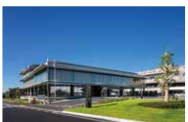
屋上の太陽光発電装置で電力の一部をまかなう町役場庁舎。
