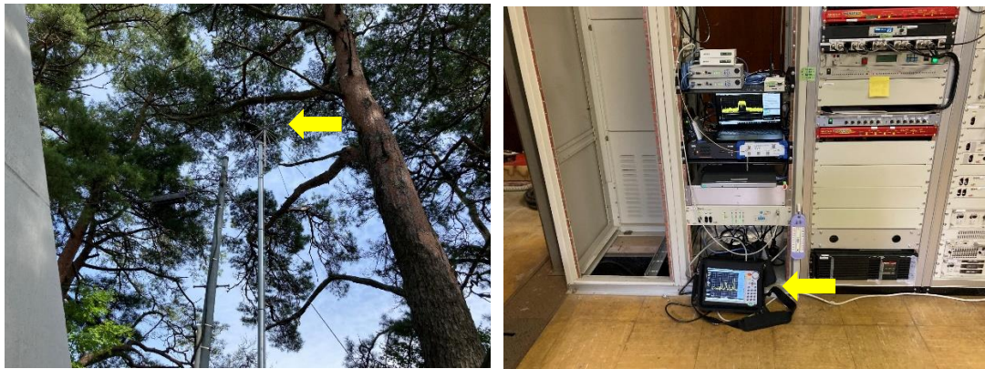
図 5.4-3 飯田局における機器設置状況 (左図: 設置した広域空中線、右図: 測定用スペクトラムアナライザ)
