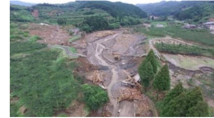
平成29年7月九州北部豪雨による 河川と農地の被害状況
