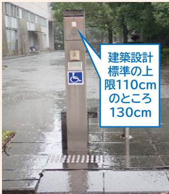
①車椅子利用者には、設置位置が高過ぎるインターホン (京都国立近代美術館)
