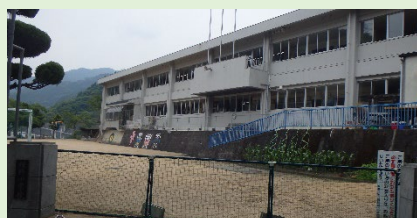
拠点として整備した種野小学校
