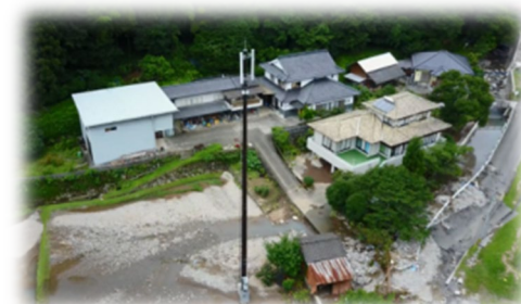
被災状況の確認
