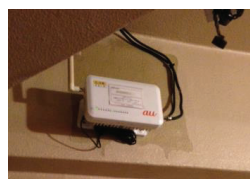
地下の店舗内に設置するレピータ (本体およびサービスアンテナ)
