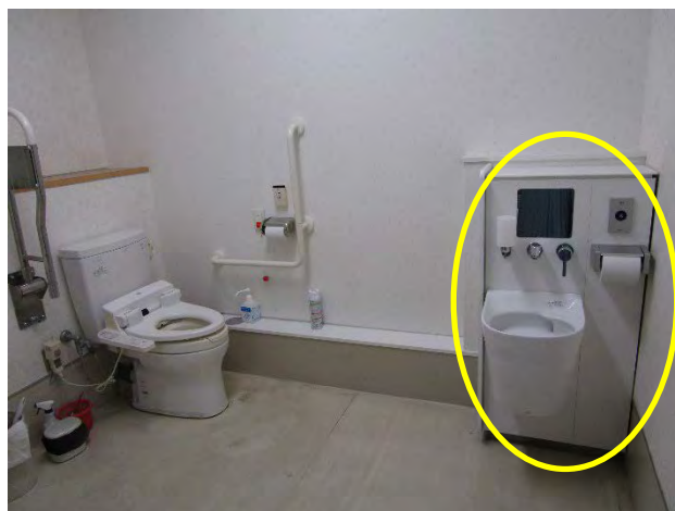
オストメイト対応設備を設置後のバリアフリースイットイレ
