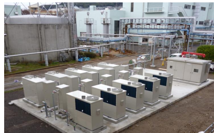
消化ガス発電設備のイメージ
