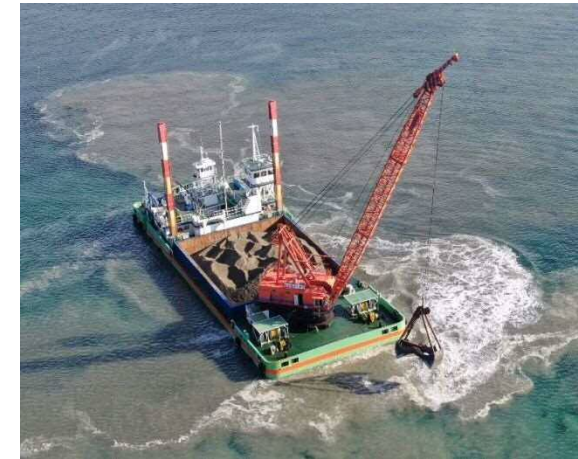
覆砂の施工状況
